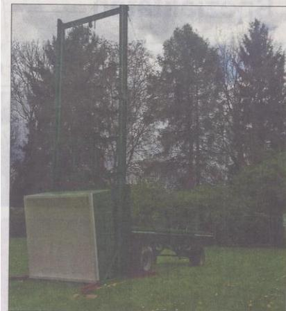
Boele. Vor genau 20 Jahren konstruierte und baute der Boeler Schützenbruder Burckhard Voigt den Vogelstand des SV Boele 1834. In diesem Jahr war eine Grundrenovierung fällig. Die Anlage wurde komplett sandgestrahlt, grundiert und neu lackiert. Der Holzboden auf dem Anhänger wurde durch Gitterrost ersetzt. Ebenfalls vor zwei Jahrzehnten wurde auch die Sportstätte eingeweiht, die jetzt auf elektronische Ringauswertung umgebaut wurde und voraussichtlich im Juli eingeweiht wird. (Foto: SV Boele)
